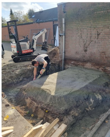
Fundering nieuwe aanbouw
